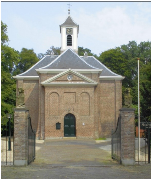
Figuur 2 De Nederduits Gereformeerde (later Nederlands Hervormde) Kerk aan het Noordereinde 14 in 's-Graveland
