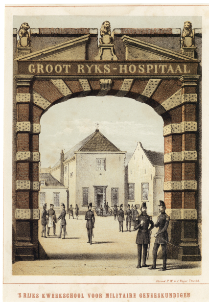
Utrecht, toegangspoort militair hospitaal ca 1860, cat. nr. 38260, collectie HUA
